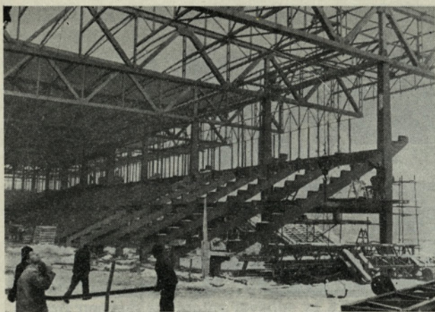
Sl. 9. Pogled na nosilno ogrodje tribun na jugovzhodni strani med montažo
