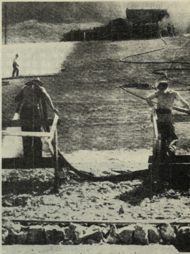
»Aliva 300« — betoniranje brežin akumulacije Birgl — Avstrija
