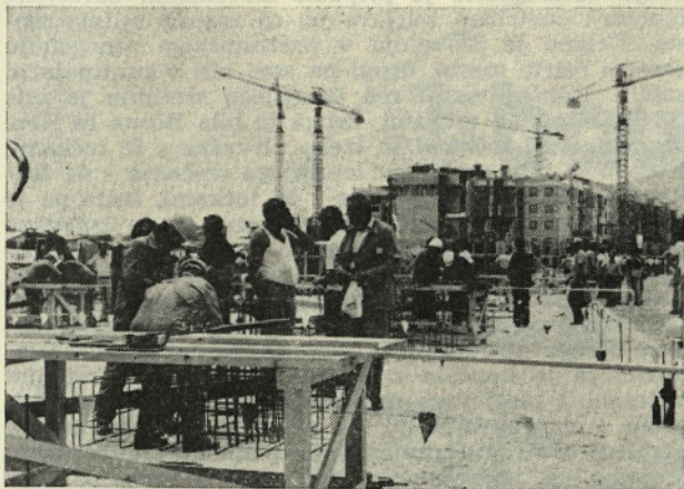
Slika 3. Gradbišče nove mariborske stanovanjske sosese Nova vas IIa je bilo prizorišče letošnjega tekmovanja
