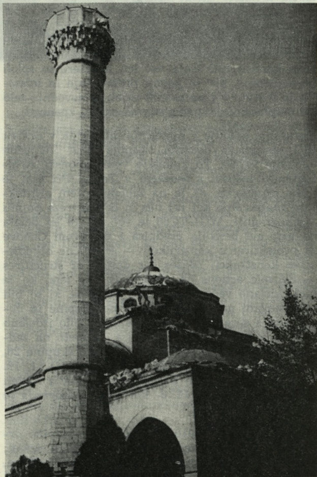
Slika 5. Banja Luka 1969. Poškodba džamije
