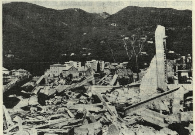
Slika 8. Črna gora, Bijela 1979. Porušitev ladjedelniskih zgradb
