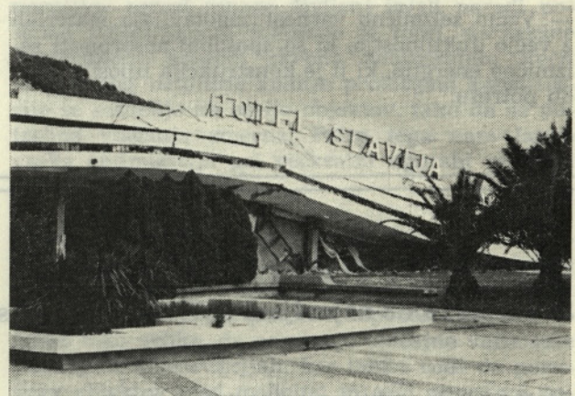
Slika 9. Črna gora, Budva 1979. Porušitev hotela
