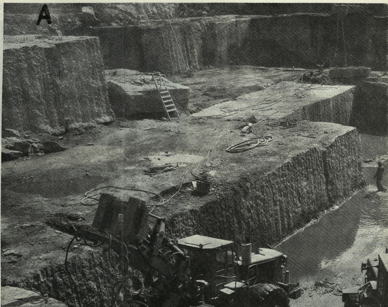
Fotografija modernega kamnoloma A — minsko polje, pripravljeno za odstrel Nakladalniki nadomeščajo vitla in »Derick« dvigala (brošura Tamrock)
