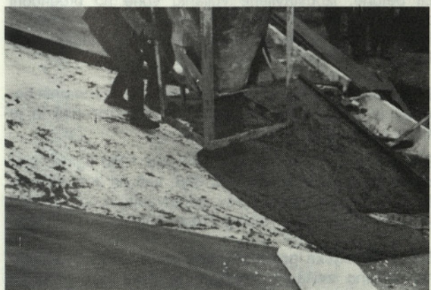
Slika 3. Drobnazrnati visoko aerirani betoni z mehko plastično konsistenco in večjo prostorninsko maso
