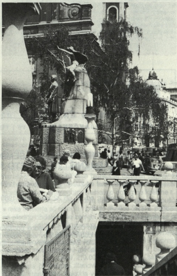
Slika 2. Del prenovljene balustrade na Tromostovju
